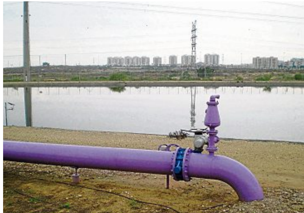
SISTEMA ESPECIAL de Israel reutiliza água de esgoto para irrigação e é identificado pela cor roxa
